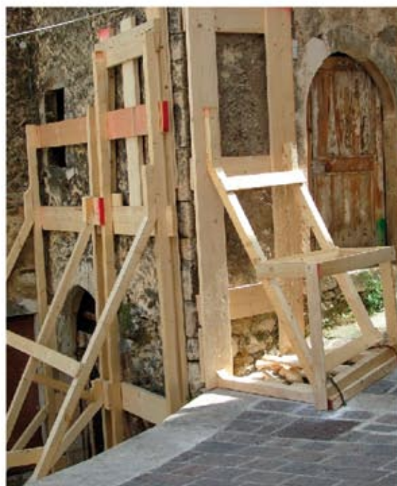
In basso Edifici pericolanti e tendopoli Acciano (AQ)
